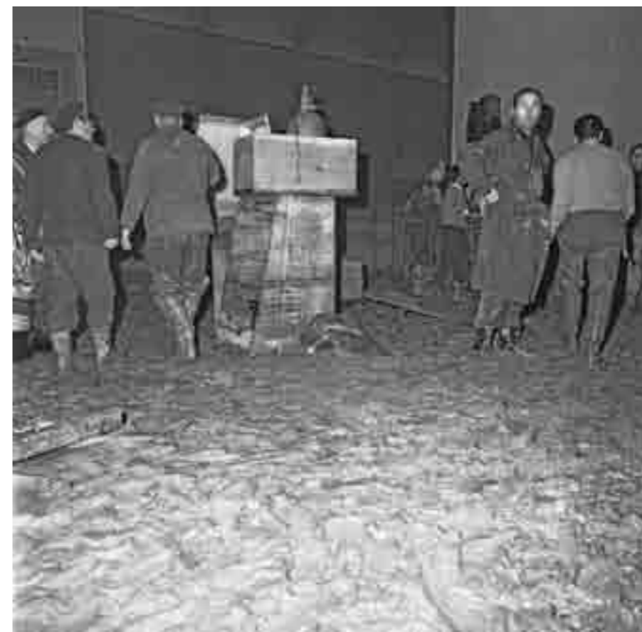
Fig. 8 - Complesso degli Uffizi, Vecchia Posta, il Gabinetto Fotografico alluvionato
