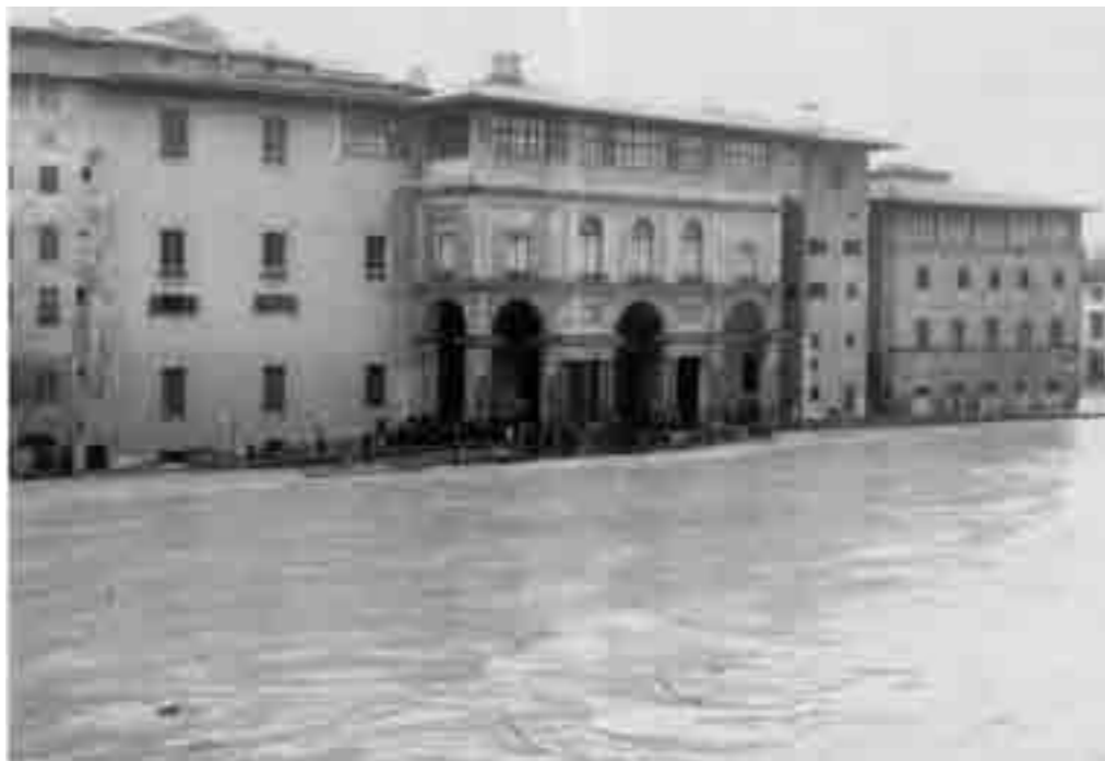
Figg. 2-3 - Vedute del Loggiato e della Galleria degli Uffizi, del Ponte Vecchio e del Corridoio vasariano durante la piena del 4 novembre 1966
